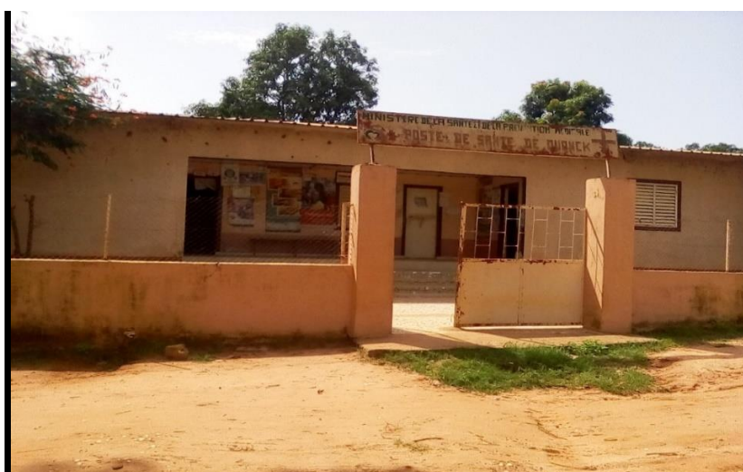
Poste de santé de Ouonck
