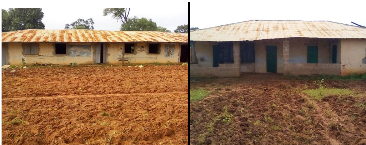
Un bâtiment de cours et un bloc administratif en abris provisoires au CEM de Souda
