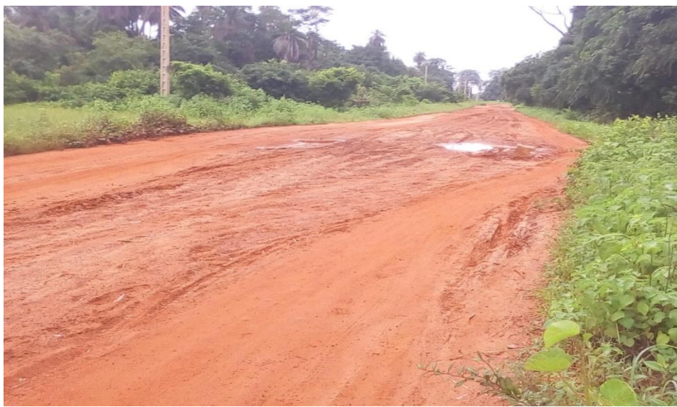
Piste principale d'accès à la commune « Boucle des Kalounayes »
