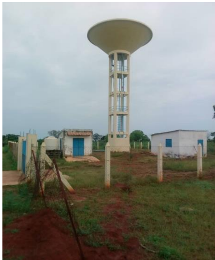
Forage de Souda réalisé par l'Etat en 2018
